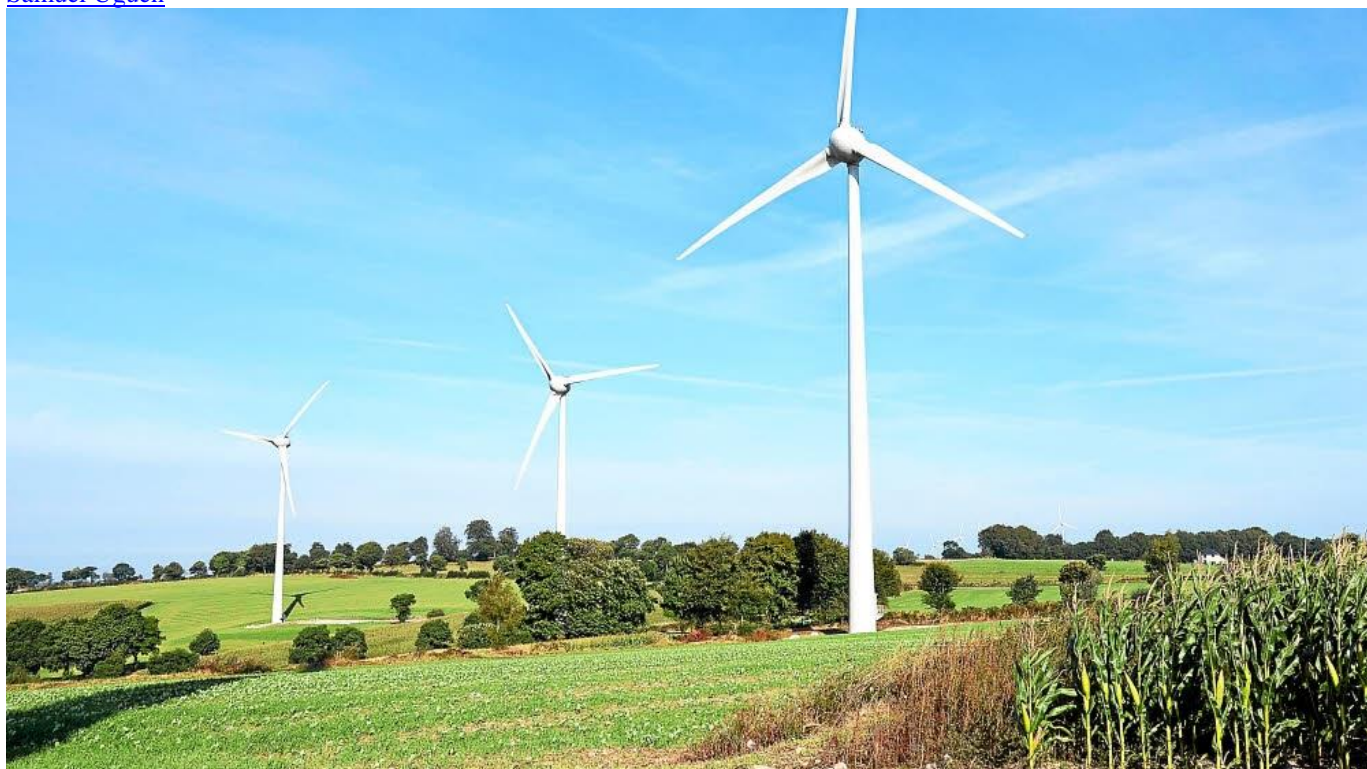
Le parc éolien du Placis-Vert du Mené, installé sur le territoire de la commune déléguée de Saint-Gouéno, a été inauguré hier.
