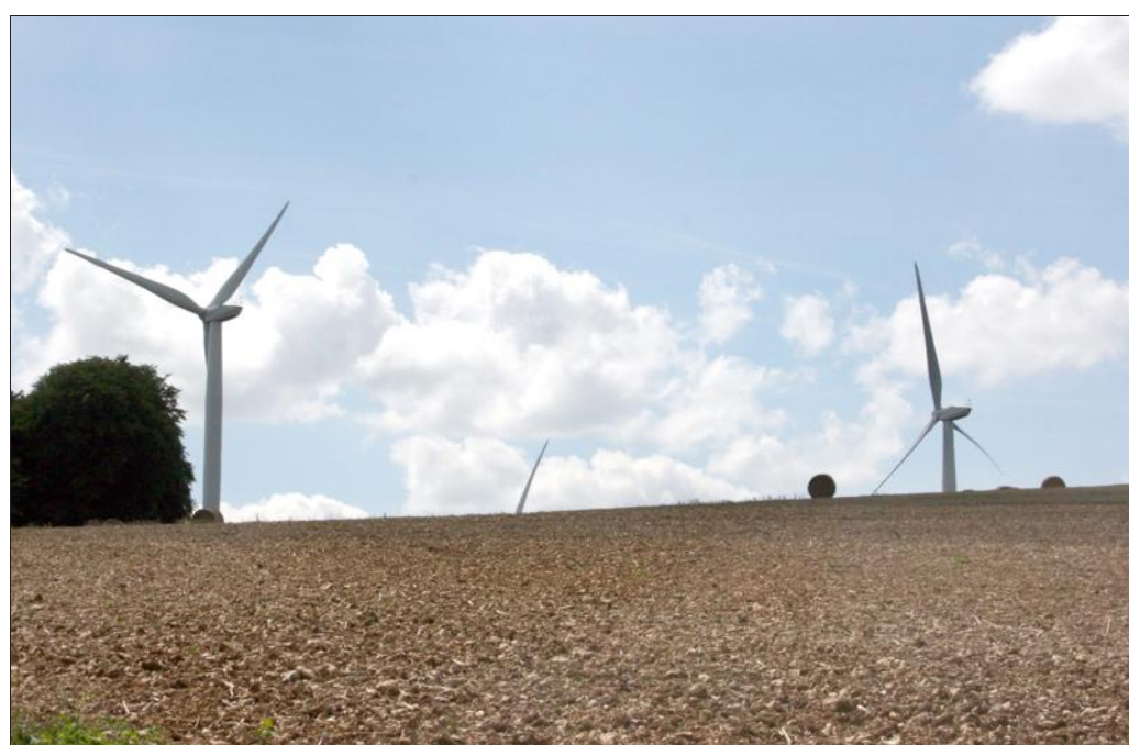
■ Six éoliennes sont installées sur des terrains communaux de Baudignécourt.
